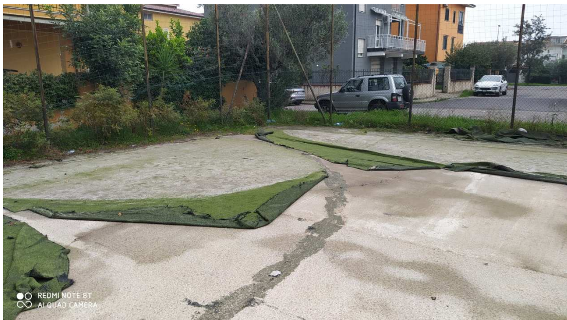
5. Vista interna Lato Sud-est
