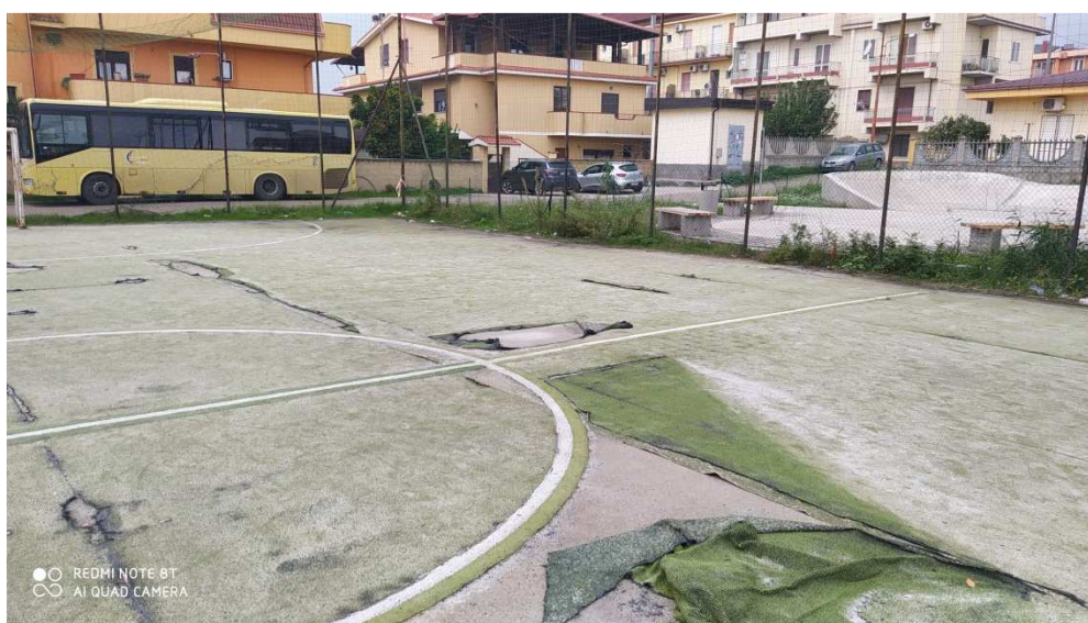
6. Vista interna Lato Sud-ovest
